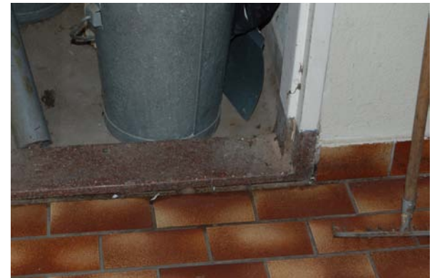
Verspreid door het gebouw zijn in verschillende kleur en afmetingen in terrazzo uitgevoerde onderdorpels aangebracht, waarvan de meesten ondanks de slijtsporen niet oorspronkelijk kunnen zijn. Van de afgebeelde onderdorpels is alleen de dorpel uiterst rechts die behoort bij de werkkast naast de voordeur uit de bouwtijd.
