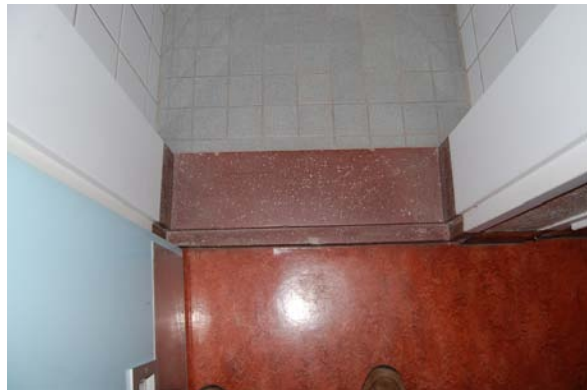
Verspreid door het gebouw zijn in verschillende kleur en afmetingen in terrazzo uitgevoerde onderdorpels aangebracht, waarvan de meesten ondanks de slijtsporen niet oorspronkelijk kunnen zijn. Van de afgebeelde onderdorpels is alleen de dorpel uiterst rechts die behoort bij de werkkast naast de voordeur uit de bouwtijd.
