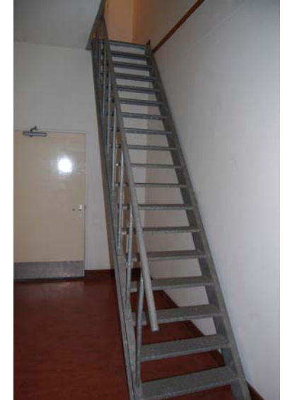
Inpandig aan het eind van de gang op de verdieping geplaatste brandtrap.
