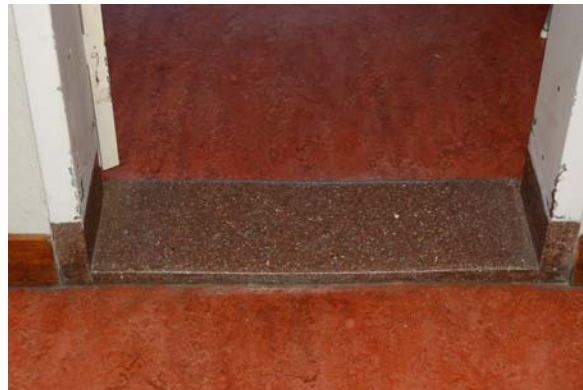
Verspreid door het gebouw zijn in verschillende kleur en afmetingen in terrazzo uitgevoerde onderdorpels aangebracht, waarvan de meesten ondanks de slijtsporen niet oorspronkelijk kunnen zijn. Van de afgebeelde onderdorpels is alleen de dorpel uiterst rechts die behoort bij de werkkast naast de voordeur uit de bouwtijd.
