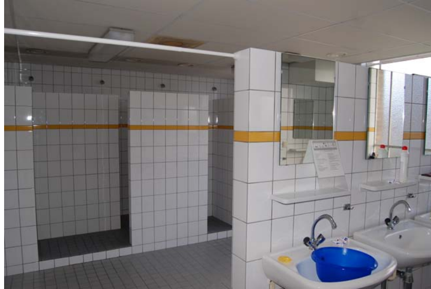
Overzicht van de sanitaire ruimte op de verdieping die ter plaatse van de voormalige poetskamer gesitueerd is.
