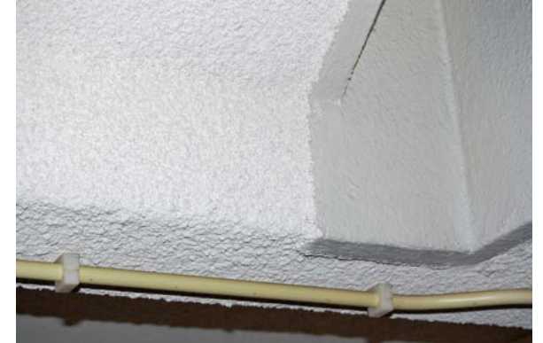
Voorbeelden van toegepaste wand- en plafondafwerkingen. Links een uit tegels opgebouwd randje dat de bovenzijde markeert van de lambrisering in de voormalige eetzaal, midden een voorbeeld van een originele hoekbeschermer zoals die nog op enkele plaatsen in het gebouw aangetroffen kan worden en rechts een deel van de verdiepingsvloer die later afgewerkt is met spuitbeton.
