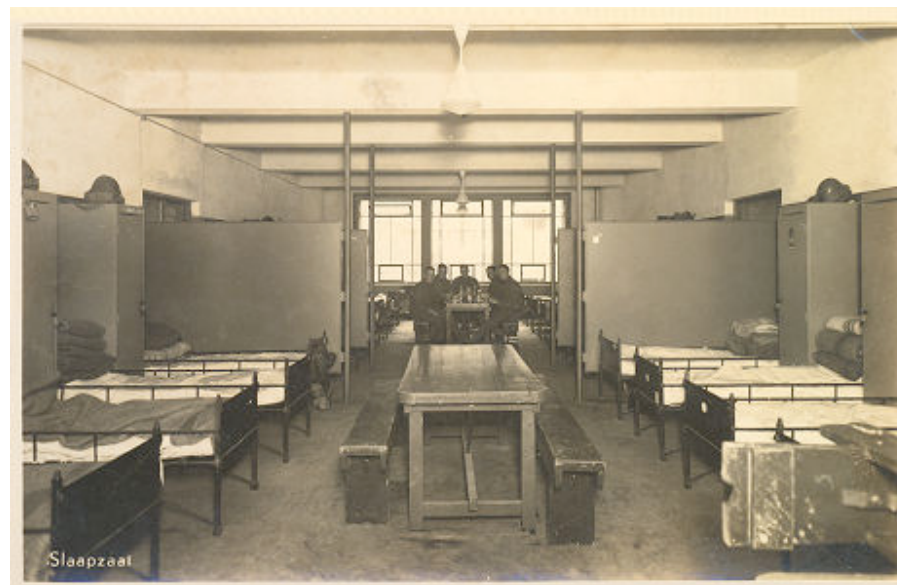
Naoorlogse foto van een manschappenkamer in de generaal De Bonskazerne in Grave. Hierop is goed te zien dat de betonnen vloeren in het zicht zijn en dat de slaapplekken net zoals in de Elias Beekmankazerne met schotten afgescheiden waren. De vensters op de achtergrond vertonen grote gelijkenis met die van de Elias Beekmankazerne.
